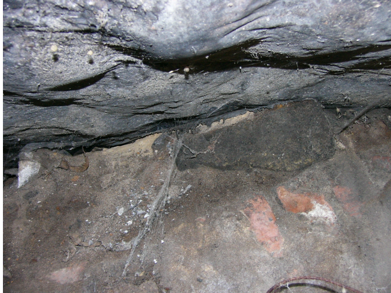
Foto opname fundering onder Centrale Bunkercomplex.
