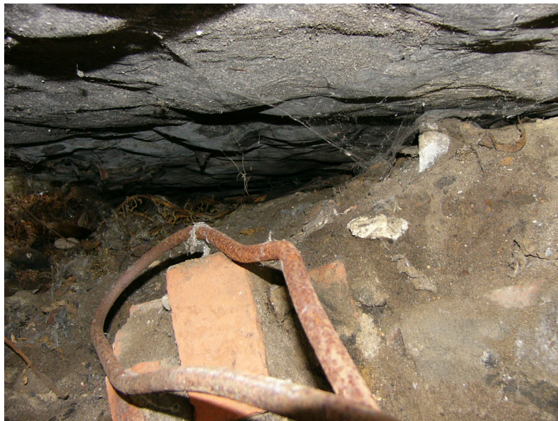
Foto opname fundering Centrale Bunkercomplex.
