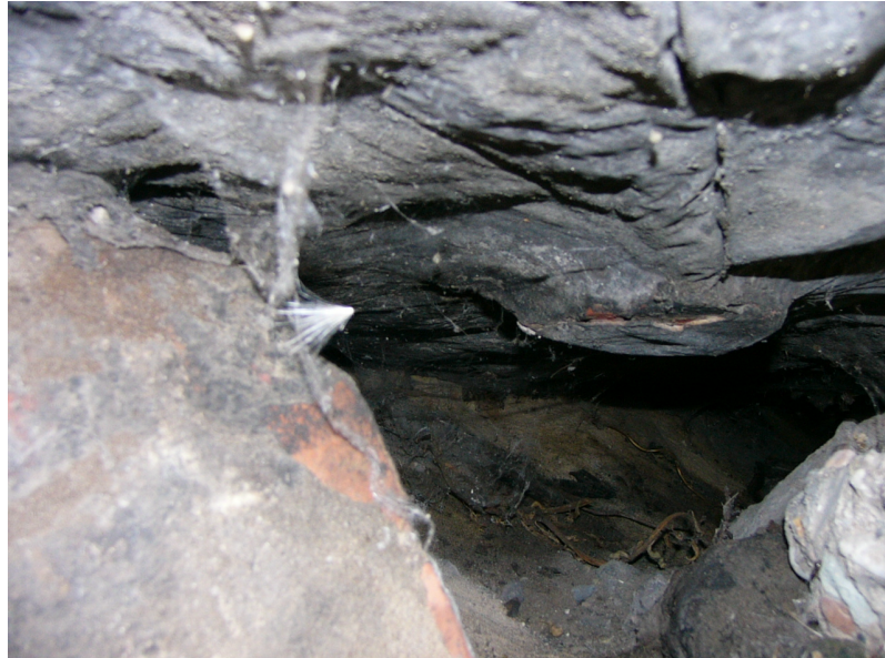
Foto opname fundering onder Centrale Bunkercomplex.
