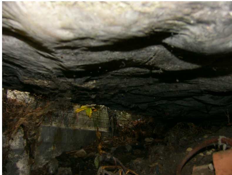
Foto opname fundering onder Centrale Bunkercomplex.
