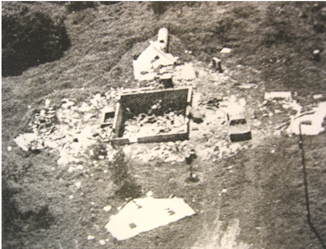
Figuur 6.15: Brokstukuitworp gasexplosie woning [10, pagina 186]
