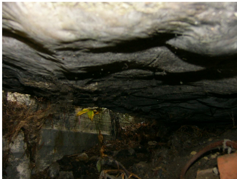
Foto opname fundering onder Centrale Bunkercomplex.
