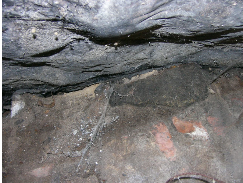
Foto opname fundering onder Centrale Bunkercomplex.
