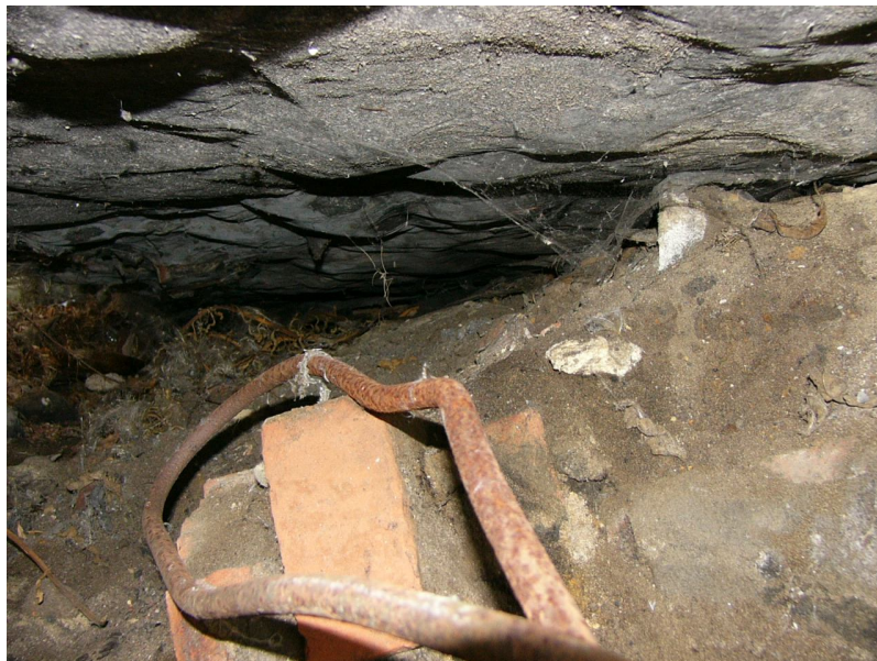
Foto opname fundering Centrale Bunkercomplex.
