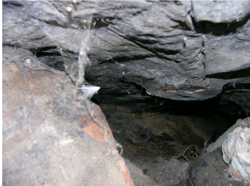
Foto opname fundering onder Centrale Bunkercomplex.
